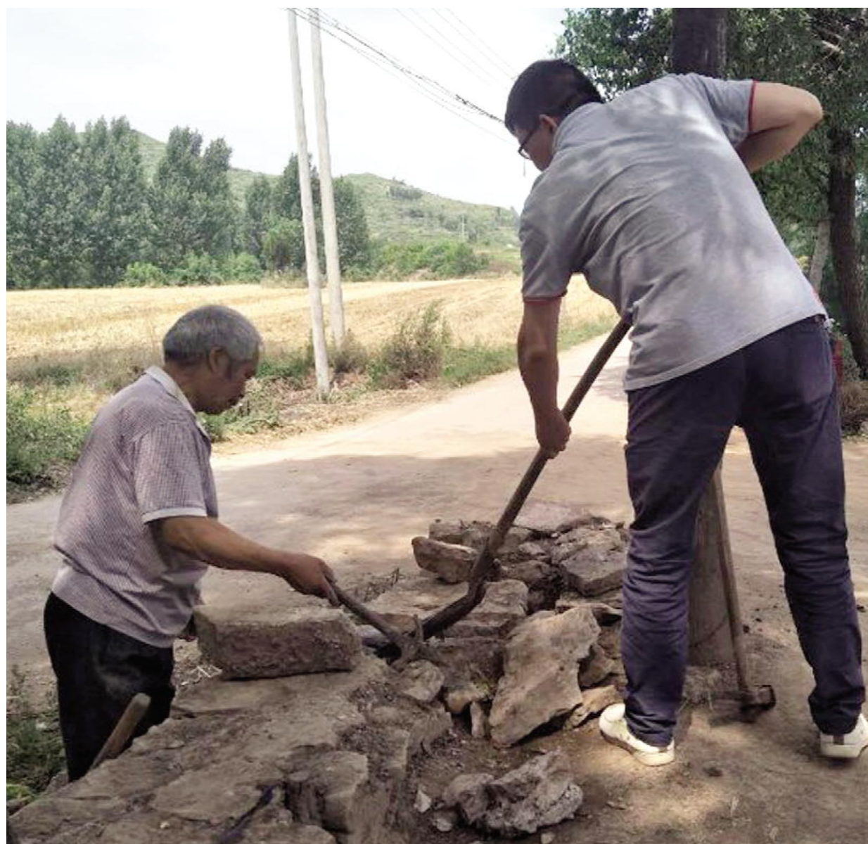
7月31日，市自来水公司帮扶干部到蟒川镇蟒窝村贫困户李土家中帮助他修筑坍塌的围墙、修缮改造房屋。 梁杨子 雷文娟 摄
