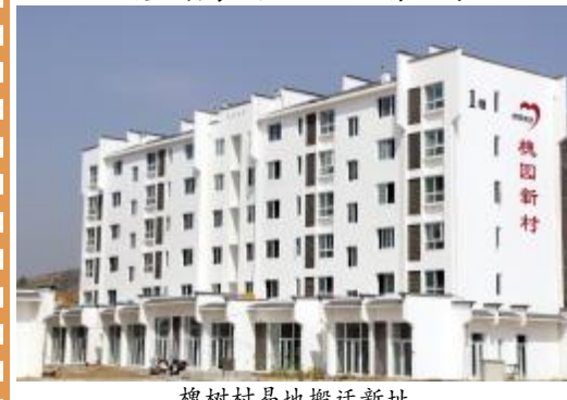
槐树村易地搬迁新址
