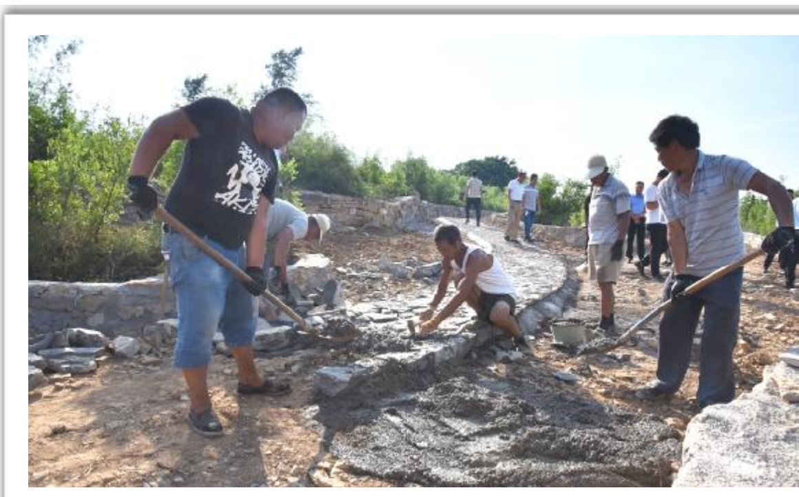
近日,在蟒河镇蟒窝村村口,十几名施工人员不顾夏日炎炎,加紧进行蟒窝村游园建设工作。 宋小亚 摄
