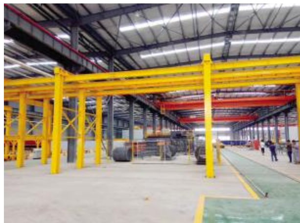
东江建筑科技PC基地生产车间
