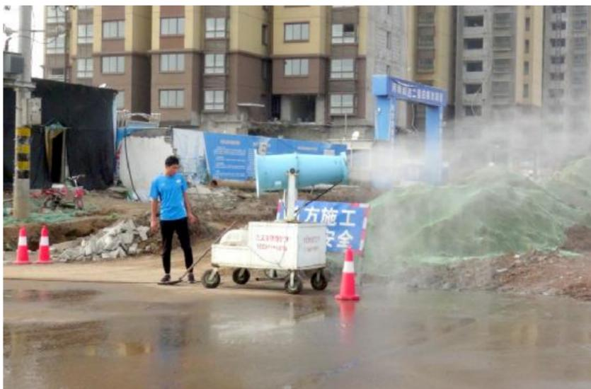
7月11日，笔者在断头路经三路和纬一路的施工现场看到，工地严格落实扬尘治理相关要求，在开挖热力管网基坑的同时，不断洒水防止扬尘飘散。
