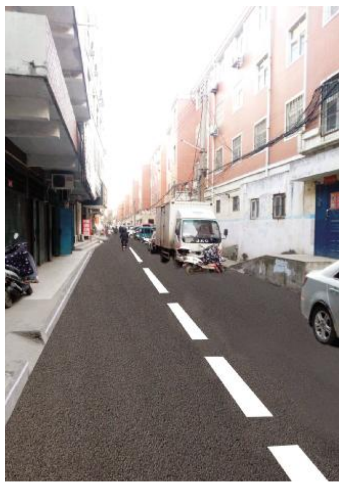
孟拐街(洗耳路—望嵩路) 道路全长349米,道路现宽4-4.5米。改造内容包括:道路地基重新夯实,排水、给水管道的拆除新建,道路照明、台阶及斜坡整治,风景墙设置、弱电入地和燃气位置预留等。
