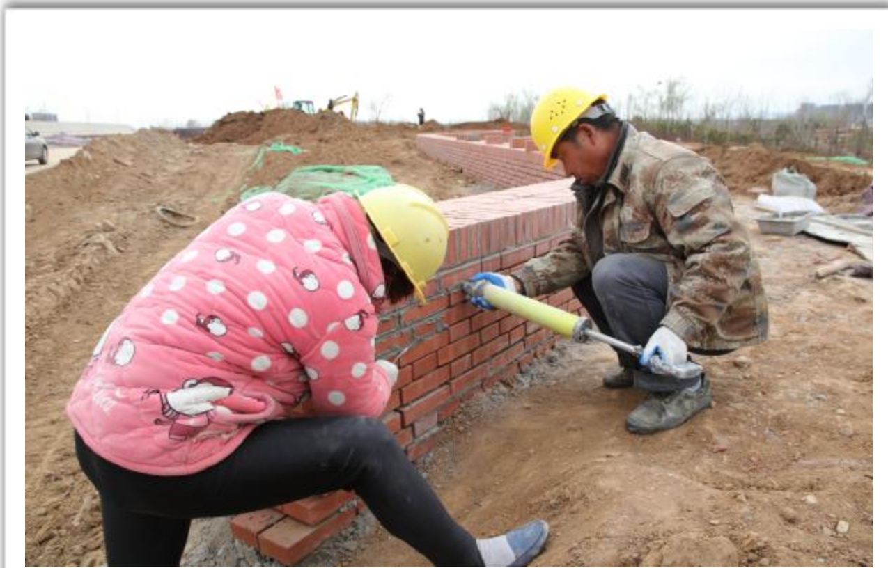
3月20日,在滨河大道项目施工现场,工人们正在一丝不苟地对清水墙进行勾缝处理。 丁亚伟 摄
