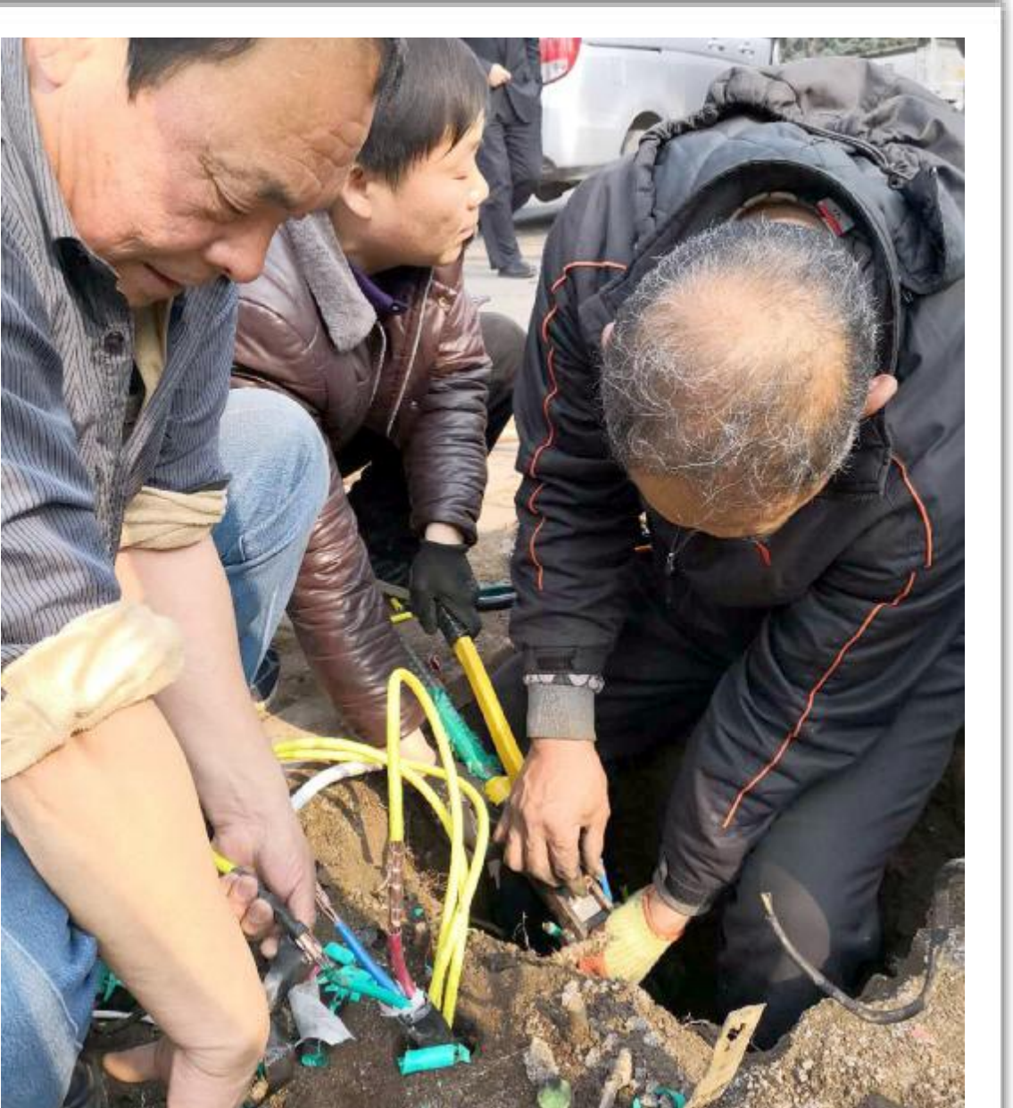
3月8日，在丹阳路建业超市门前，由于地理电缆出现故障，造成路灯不亮。市路灯管理所查到这一问题后立即组织工人们进行抢修。图为工人们抢修地理电缆现场。路灯现已恢复正常照明。 宋乐义 摄
