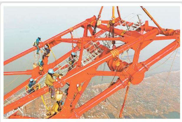
2月6日,新疆昌吉至安徽古泉±1100千伏长江大跨越工程南岸跨越塔成功封顶。至此,长江大跨越工程杆塔施 工全部完成。"昌吉至古泉"特高压输电项目起自新疆准东(昌吉)换流站,止于安徽皖南(古泉)换流站。长江大跨越 工程由2基225.2米高的跨越塔、2基66米高的锚塔组成,横跨长江3600米。图为当日在安徽省繁昌县获港镇,施工人员 在220米高空作业。 新华社发
