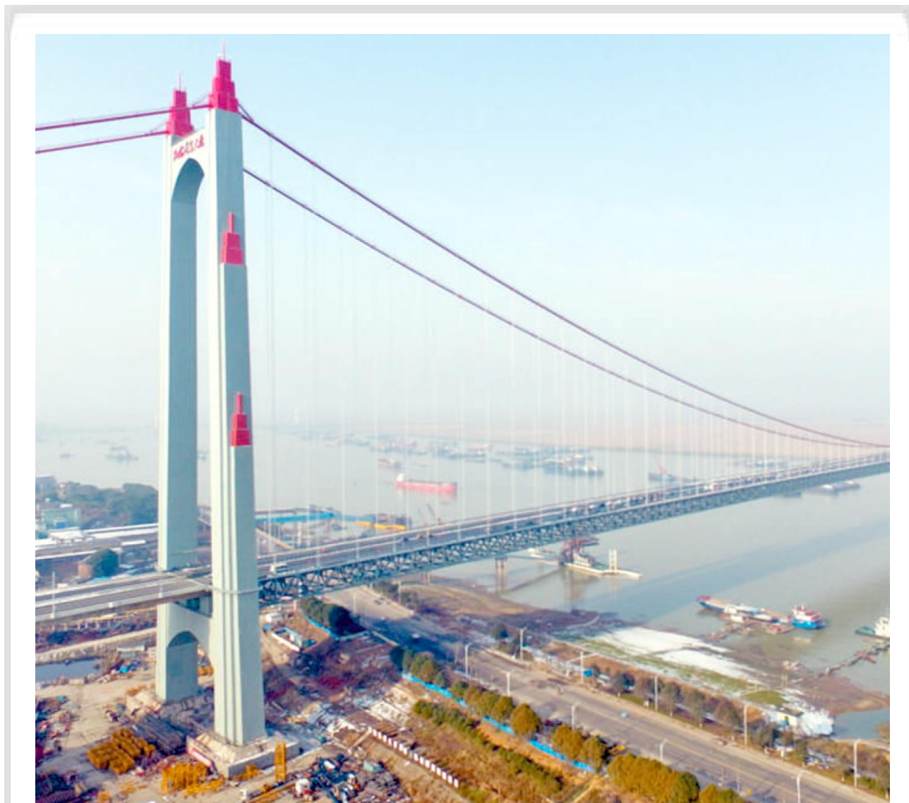
2月1日，杭（杭州）瑞（瑞丽）高速洞庭大桥建成通车，标志着杭瑞高速湖南段全线贯通。大桥主跨1480米，在钢桁加劲梁悬索桥中排名国内第一、世界第二。
