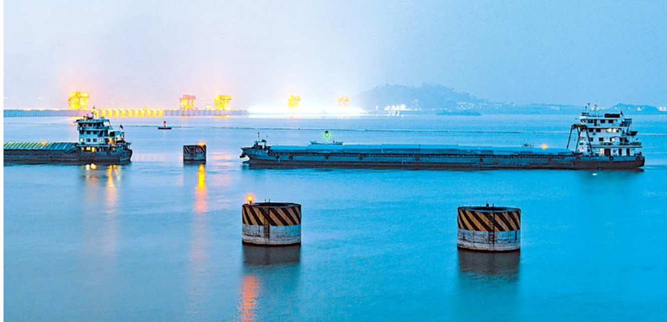
三峡通航管理局7日发布的数据显示，2017年三峡工程大坝船闸通过量增长5%以上，达到1.38亿吨，再创历史新高。上图为1月7日，货轮从三峡大坝上游引航道开进三峡五级船闸下行。
