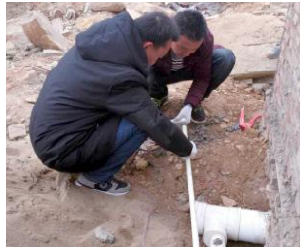
近日，市自来水公司义务为蟒川镇蟒窝村村委会厕所铺设上水和下水管道，用实际行动支持帮扶村扶贫工作。梁杨子 摄
