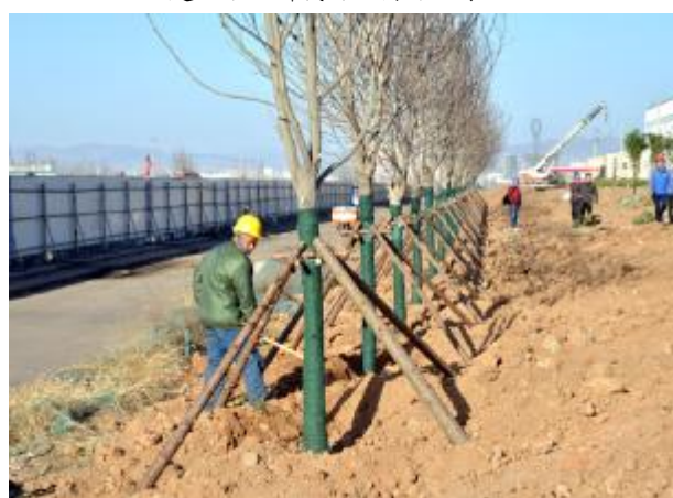
宁洛高速引线上,工人抓住有利时机栽植行道树
