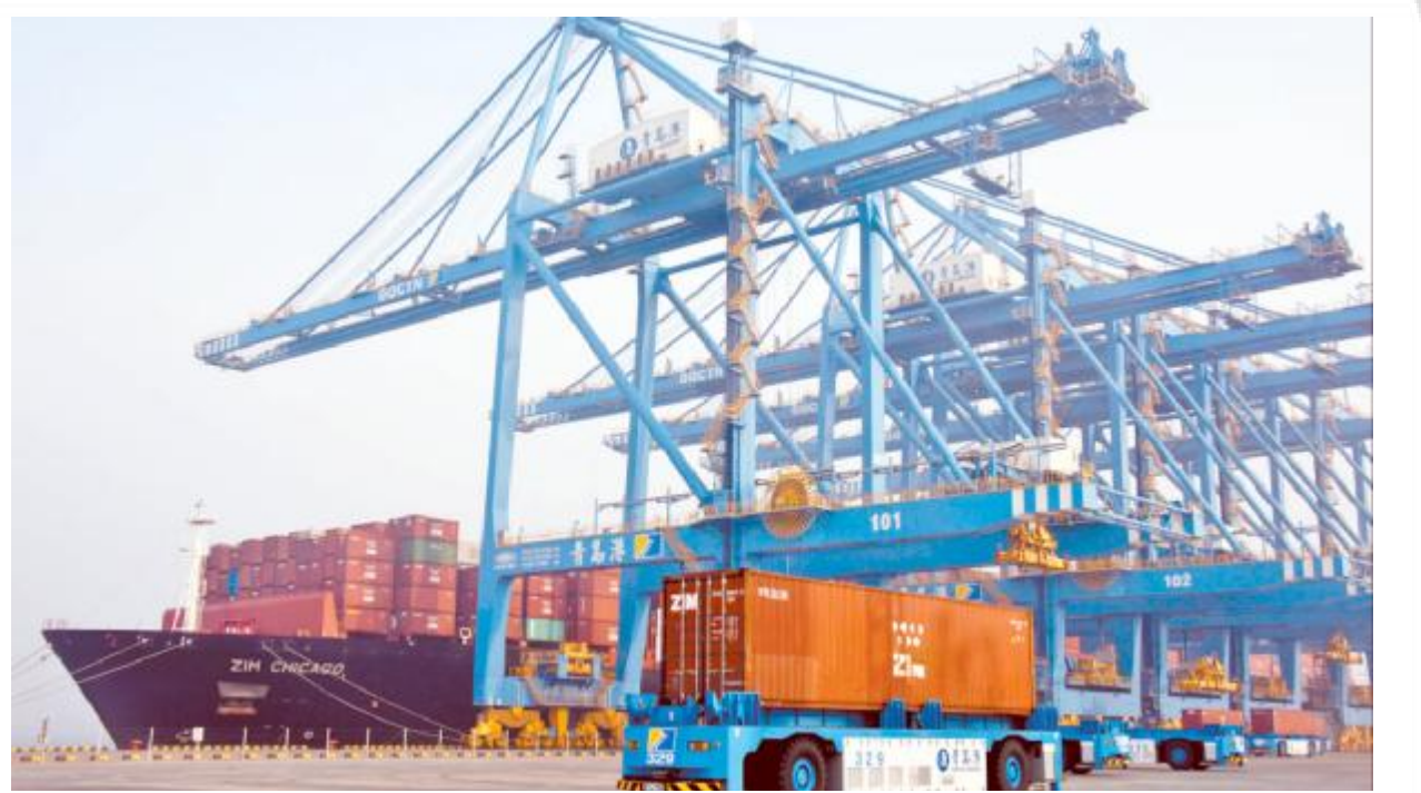
12月3日，“以星芝加哥”集装箱船作业中，青岛港全自动化集装箱码头的单机平均作业效率达到39.6自然箱/小时，创下全球自动化码头单机平均作业效率最高纪录，且全面超越人工码头作业效率，比全球自动化码头单机平均效率高50%。图为“以星芝加哥”轮船在青岛港全自动化码头装卸集装箱。 转自《人民日报》
