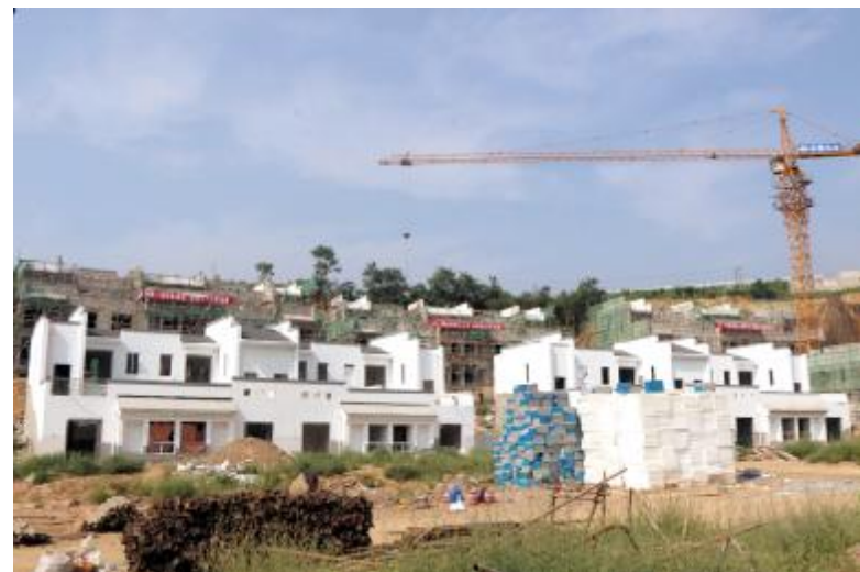
槐树村易地扶贫搬迁项目
