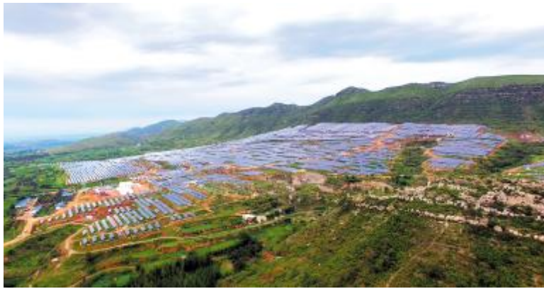
申坡村光伏发电项目
