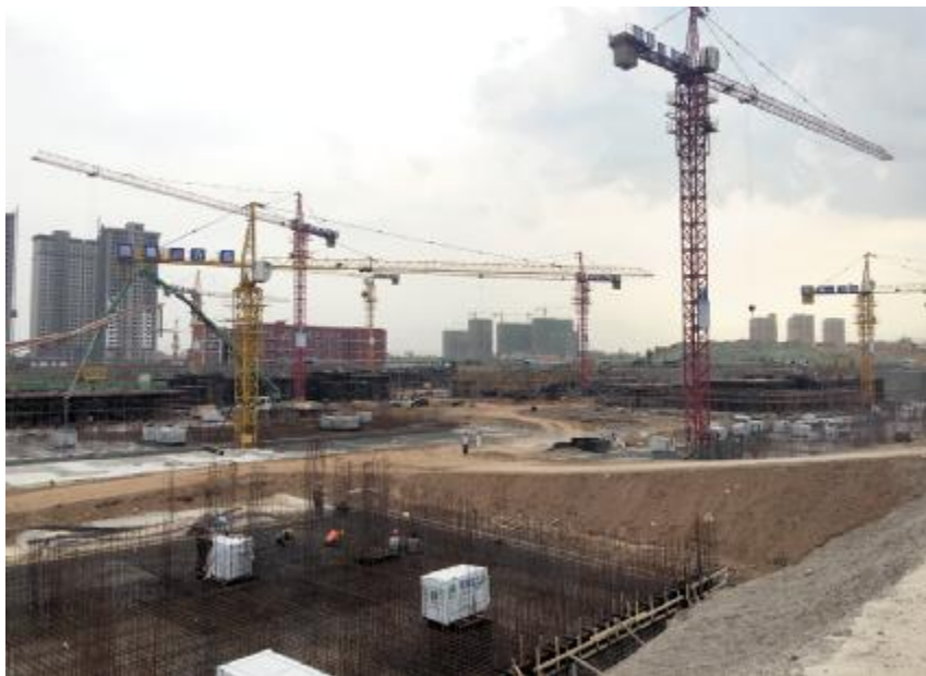
繁忙的项目建设工地
