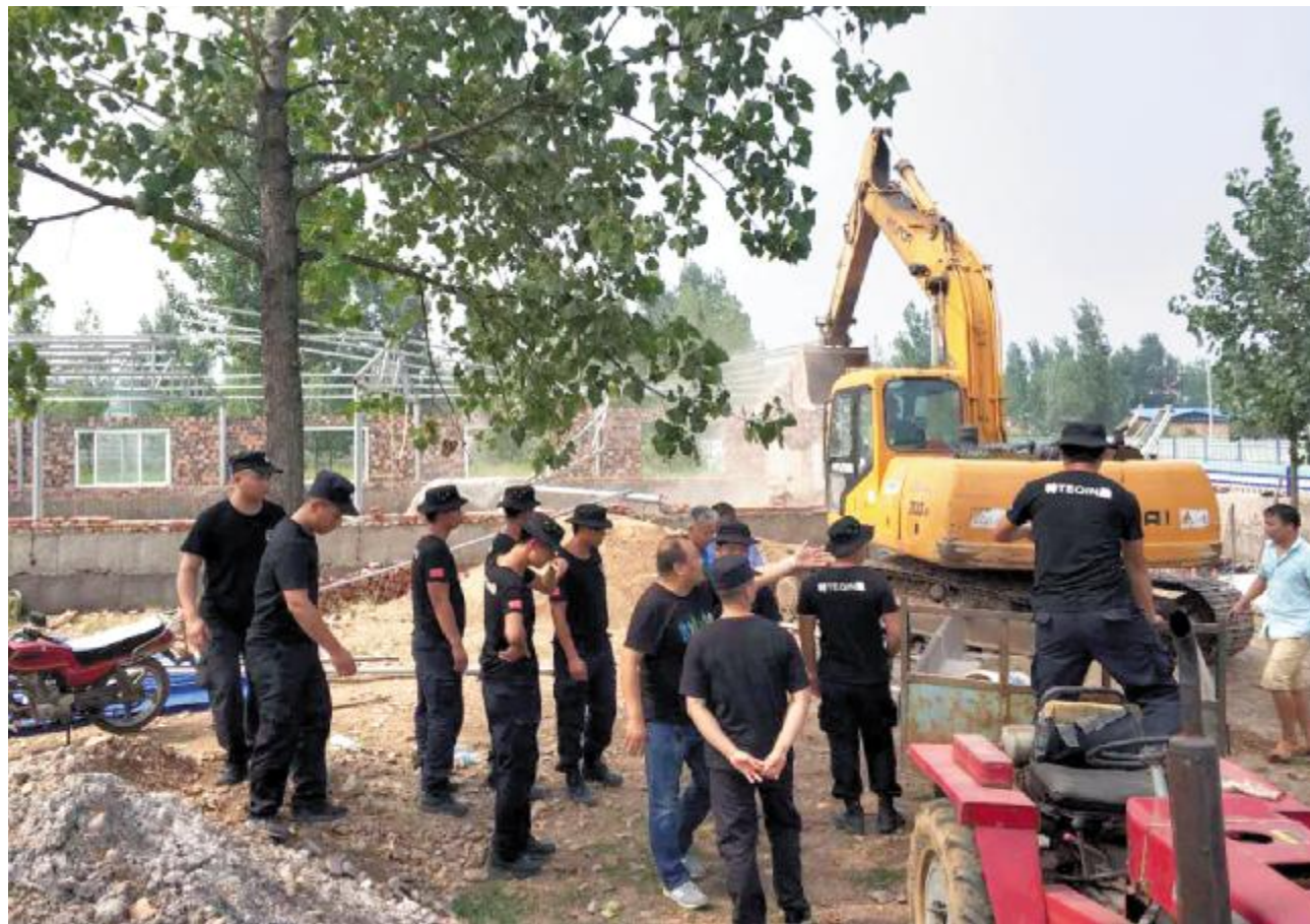
蟒川河北岸汝南街道西焦村段违建拆除现场
