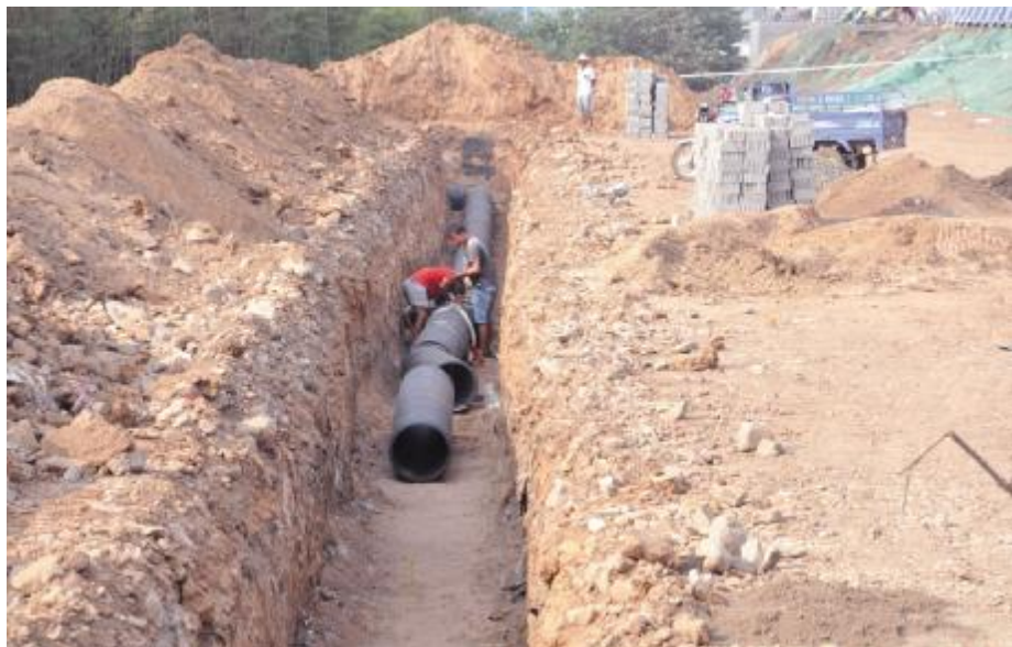
8月17日,汝河沙滩公园正在安装排水管道,完善公园基础设施建设。 刚鑫雨 摄
