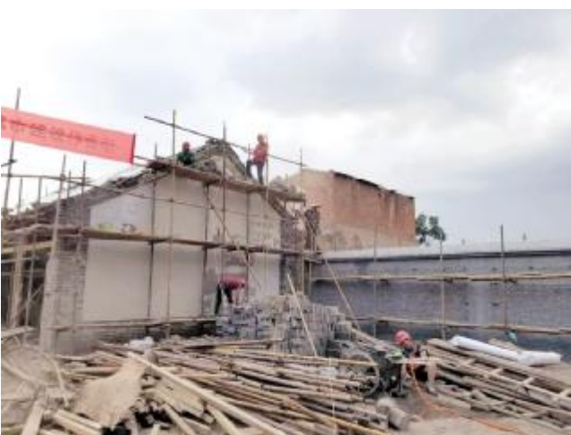
7月11日中大街提质改造一期工程启动
