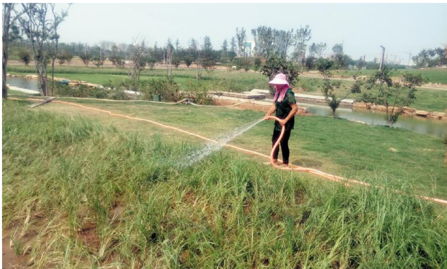
8月16日,记者在广成公园看到,为确保栽植的绿化苗木顺利成活,工人们正在浇水抗旱。李刚 摄
