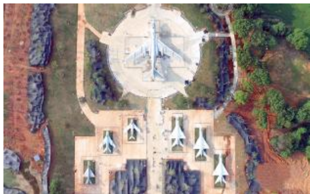
这是7月26日拍摄的南昌军事装备展示中心外景。近日,由中国建筑第二工程局有限公司施工的南昌军事装备展示中心进入收尾阶段,即将向公众开放。南昌军事装备展示中心占地300余亩,陈列着飞机、坦克、火箭炮、装甲车等多件重型武器。
