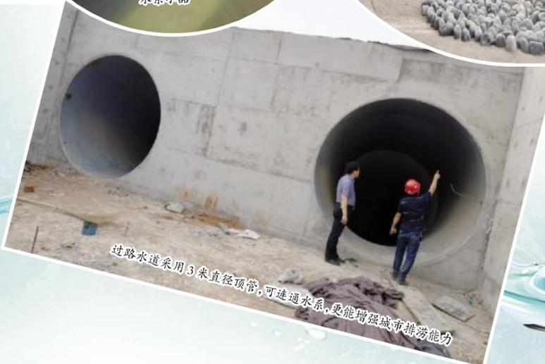
过路水道采用3米直径顶管，可连通水系，更能增强城市排涝能力
