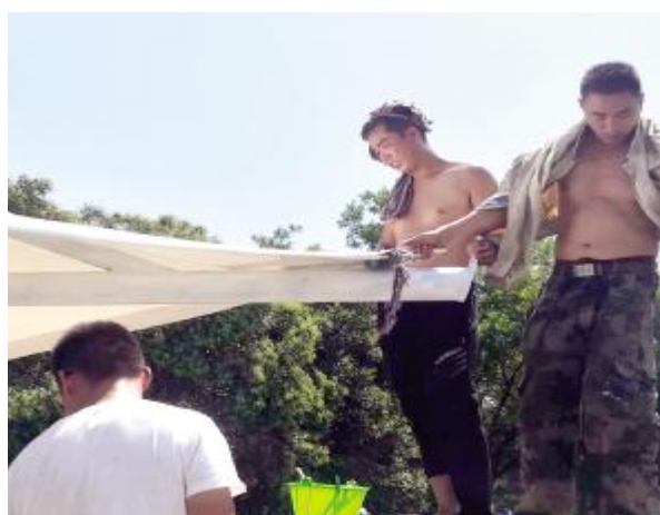
市标,工人们正在顶着烈日安装行人遮阳伞
