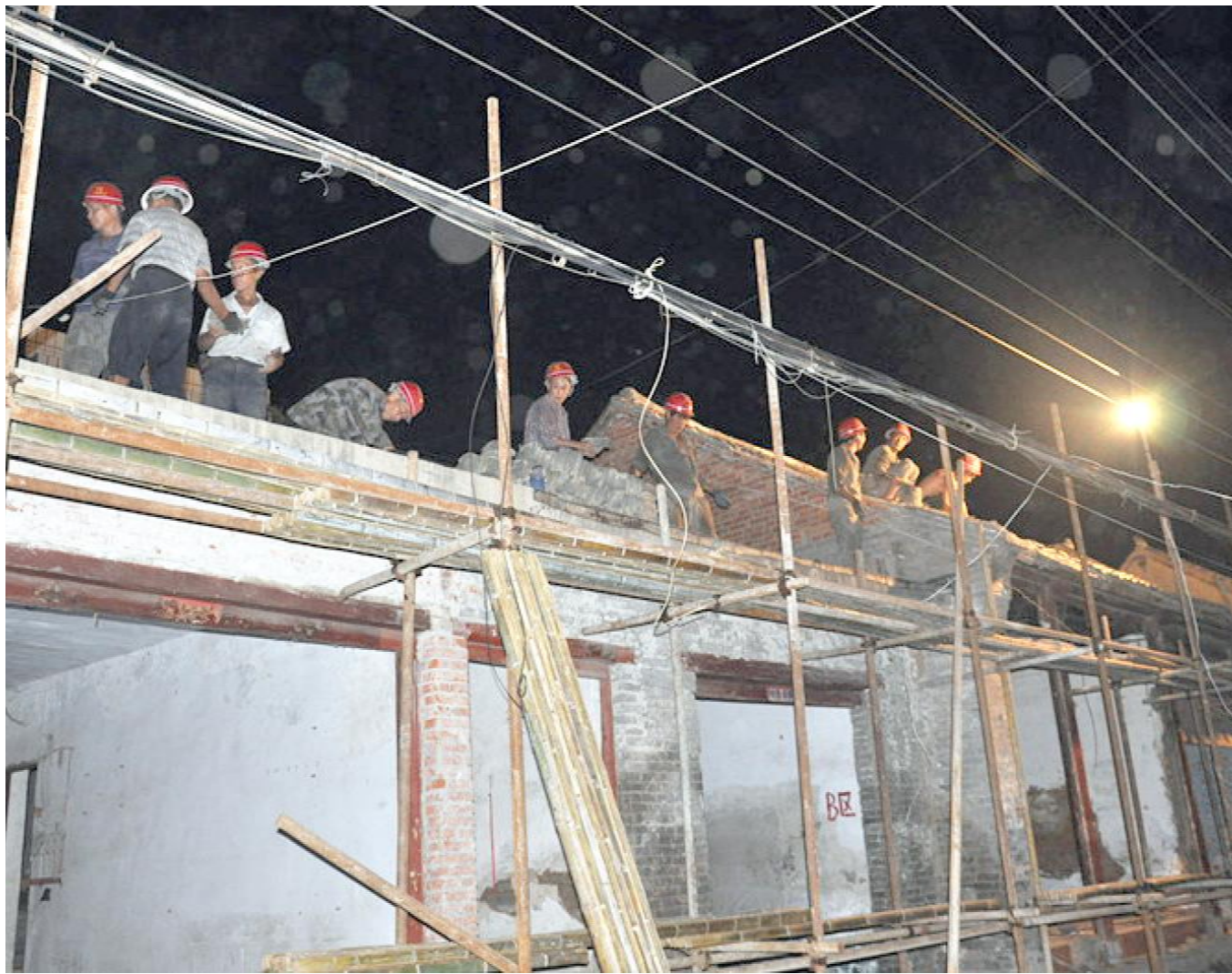
挑灯夜战 加紧施工
