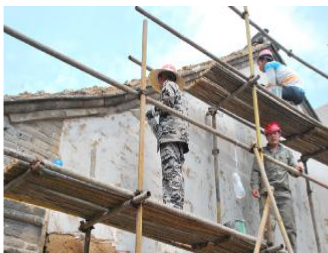
古建筑墙面外粉
