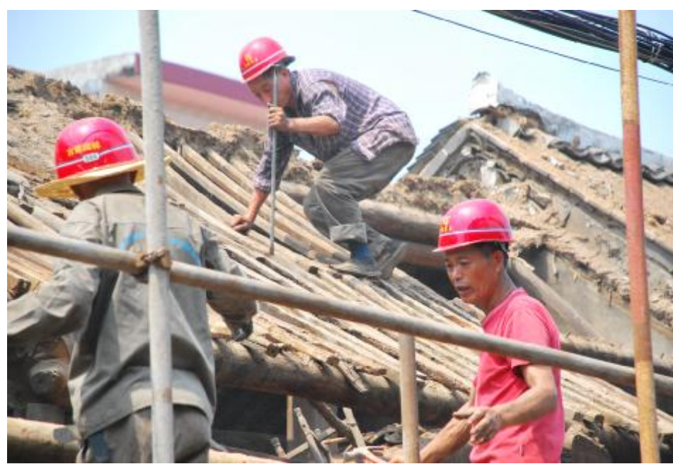
小心翼翼施工
