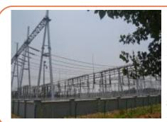
9、国家电网 220 千伏输出工程:项目总投资 2亿元,此工程从王寨广成变电站至温泉霍庄变电站,线路途经王寨、洗耳河、庙下、温泉四个乡镇(街道)。全长 17.5 千米,其中双回路架设 2.5 千米(单侧挂线),单回路架设 15.0 千米。全线共新建杆塔 59 基,其中双回路铁塔 9 基,单回路铁塔 50 基。
