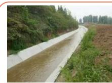
13、幸福渠水系建设:该项目建设总投资 9420 万元,治理范围为自汝州西部庙下镇杜庄自然村,向东至汝州城区,与广成河互联互通。主要是对幸福渠进行综合整治和加固,并在渠首新建橡胶坝一座,不改变渠道原设计规模,设计引水流量为5立方米/秒,设计渠首引水水位为240.7米。
