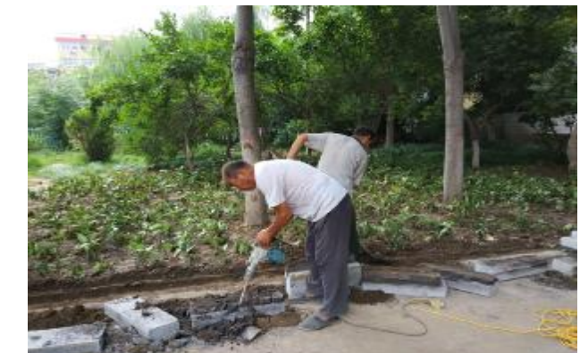
近日,煤山公园组织工作人员对园内旧道牙进行更换。
