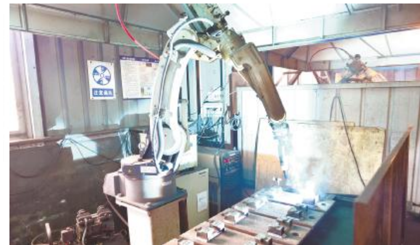
机械手臂焊接实现无人作业
