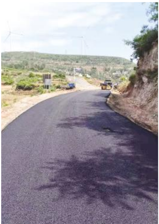
整修一新的通村道路
