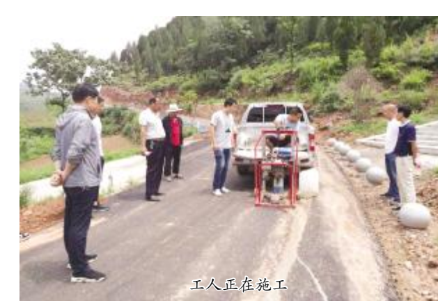
工人正在施工
