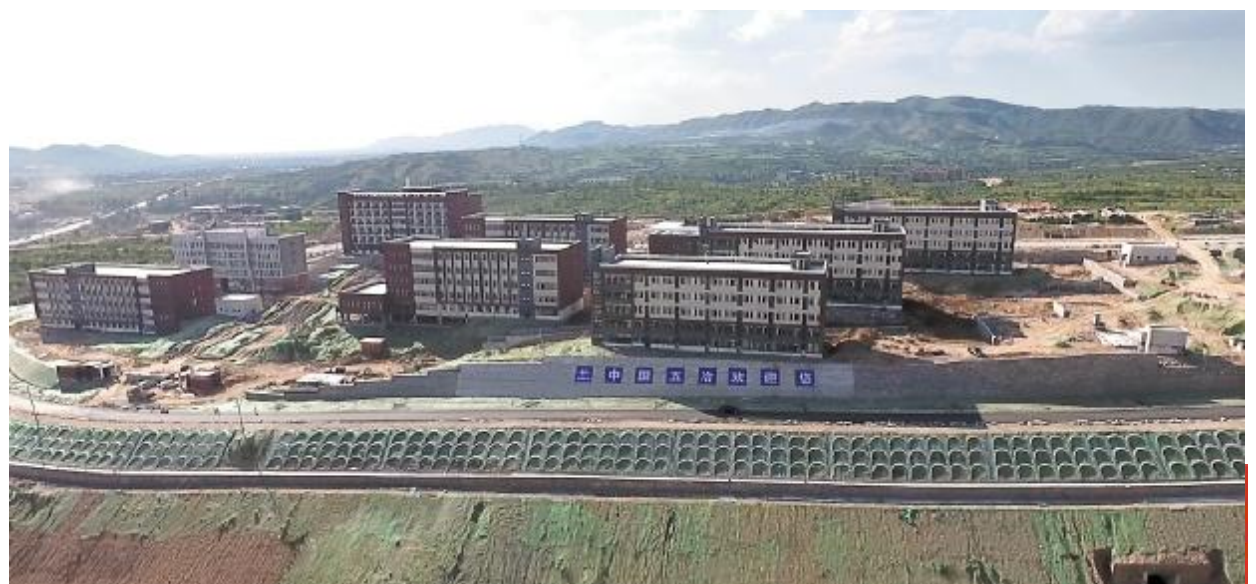
建设中的园区
